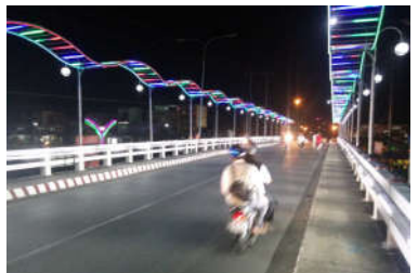
Công trình đèn Led chiếu sáng cầu Hồng Ngự
